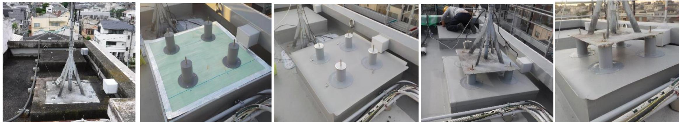
③パラペット既存防水部分への照明装置設置用アンカー新設
